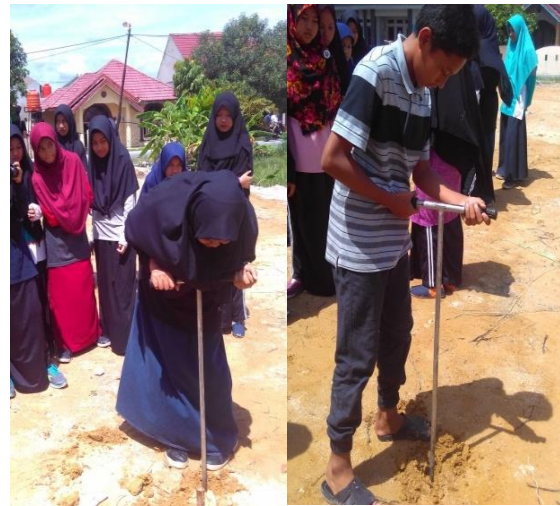
Gambar 4. Pembuatan lubang biopori
